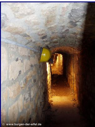
Oberhalb der Burg Blankenheim befindet sich der **Tiergartentunnel**. Dieser ist eine 1468/1469 erbaute ca. 150 m lange Wasserleitung, die die Burg mit Frischwasser versorgte. Teile des Tiergartentunnels können besichtigt werden. Weitere Informationen finden Sie bei der [NRW-Stiftung](#) und direkt unter [www.tiergartentunnel.de](http://www.tiergartentunnel.de), wo Sie auch Informationen zu den Führungen erhalten.
